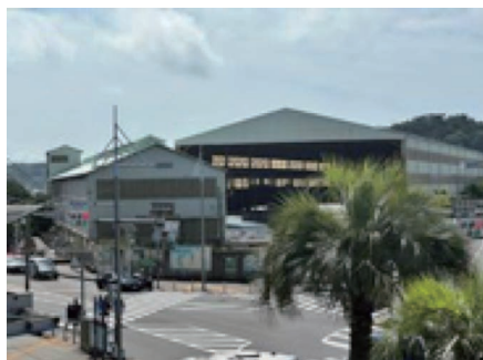
(浦賀駅から見た浦賀ドック)
